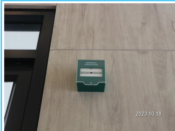
รูปที่ 3-39 อุปกรณ์แจ้งเหตุแบบใช้มือ
