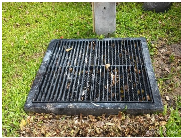
รูปที่ 3-35 ตะแกรงครอบท่อระบายน้ำ
