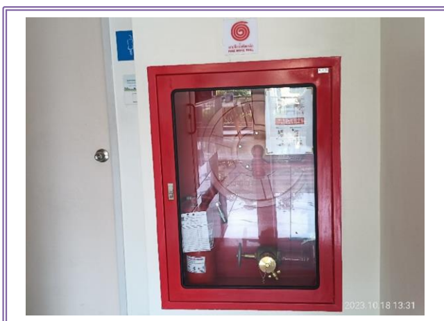
รูปที่ 2.7-1 ตู้เก็บสายฉีดน้ำดับเพลิง
