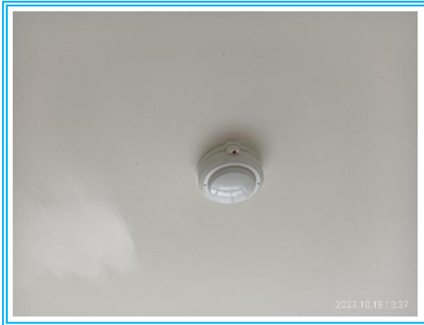
รูปที่ 3-41 อุปกรณ์ตรวจจับความร้อน
