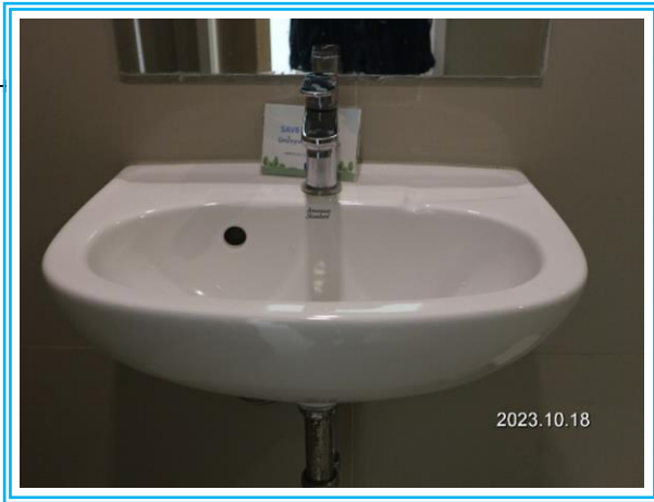
รูปที่ 3-23 สุขภัณฑ์แบบประหยัดน้ำ
