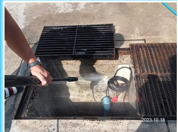
รูปที่ 3-38 พนักงานทำความสะอาดตะแกรงของบ่อดักขยะ
