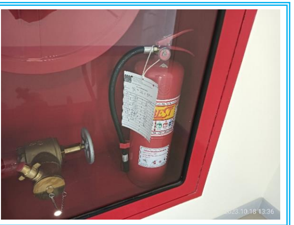
รูปที่ 3-44 ถังดับเพลิงเคมี
