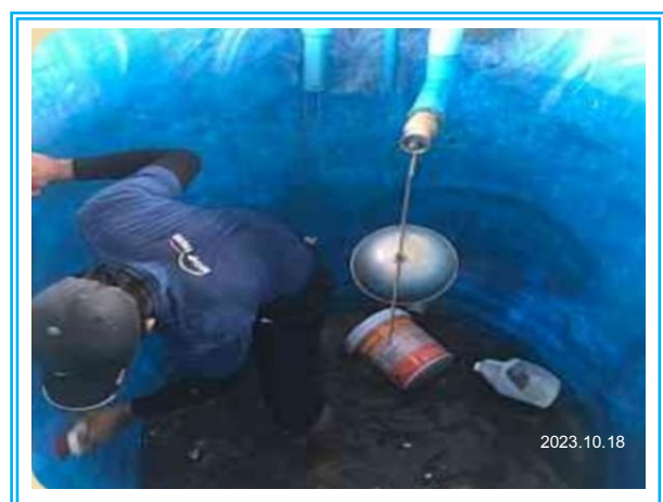
รูปที่ 3-21 พนักงานล้างถังสำรองน้ำของโครงการ
